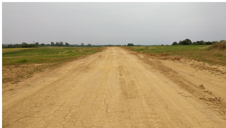
Foto 8: Particolare del tratto centrale della pista di servizio per il trasporto della risorsa estratta, da Sud.
