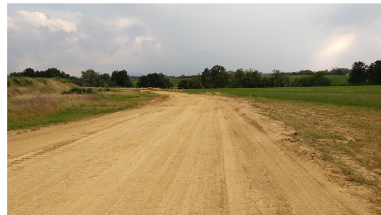
Foto 9: Particolare del tratto centrale della pista di servizio per il trasporto della risorsa estratta, da Nord.
