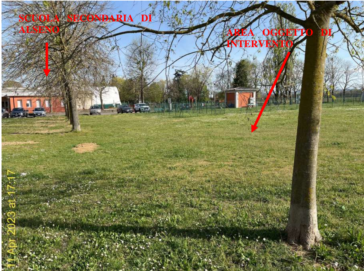
vista complessiva dell'intervento
