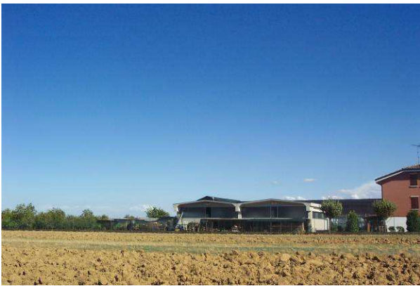
vista del fronte est degli insediamenti esistenti
